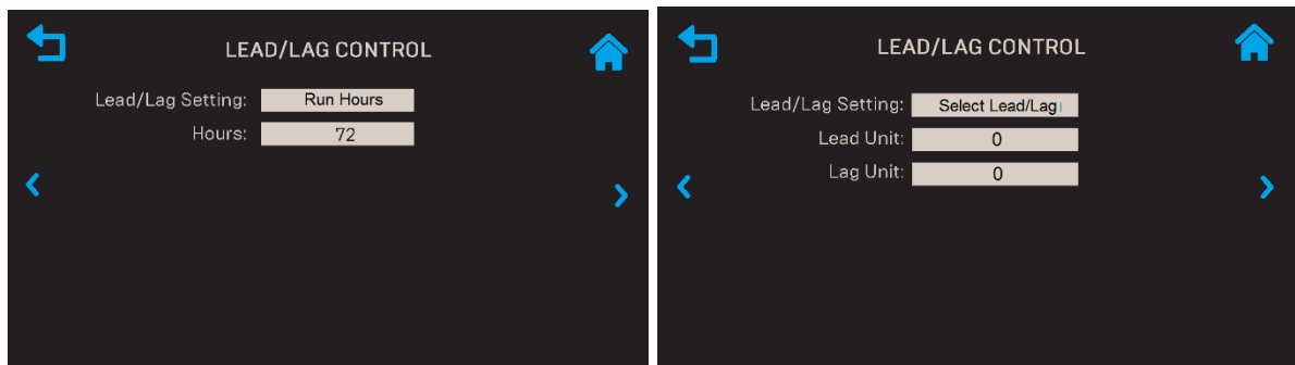
Figure 8-10 : Écran de Lead/Lag Control
